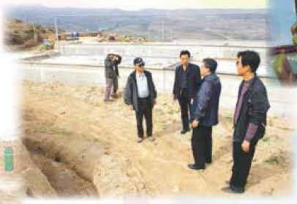
甘肅省 麥積 渭南鎮 蘇山村 災後重建
